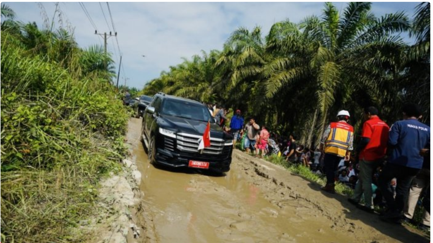
Mobil Presiden Republik Indonesia Ketika Melewati Jalan Rusak di Labura
